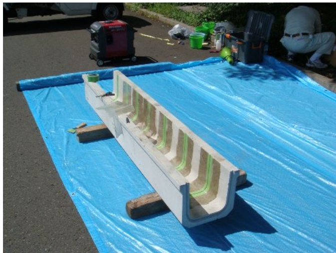
3. 目地補修用シート工法
