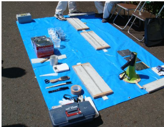
4. テープ補修工法
