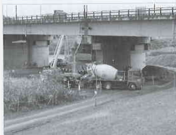
写真-1 巻立てコンクリート打設状況
